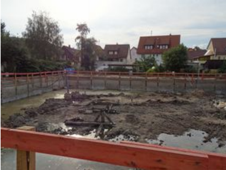
Baugrube hinter dem "Ochsen"
