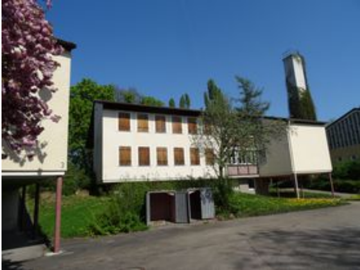
Ehemaliges Wohnhaus auf der Hangweide
